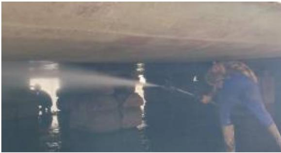
Gambar 3. Penyemprotan *Water Jet*
