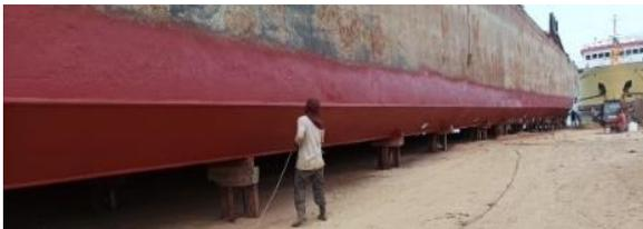
**Gambar 8.** Pengecatan Lapisan Pertama
