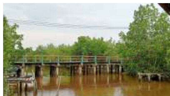
Gambar 1 Kondisi Eksisting Jembatan
