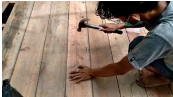
Gambar 7. Pemasangan lantai
