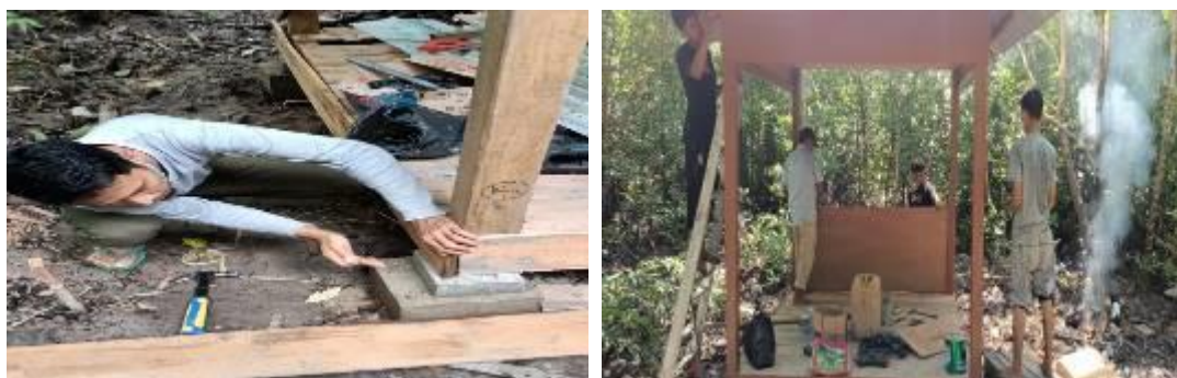
Gambar 8. Pemasangan list plank bawah, Pemasangan dinding, dan Proses pengecatan
