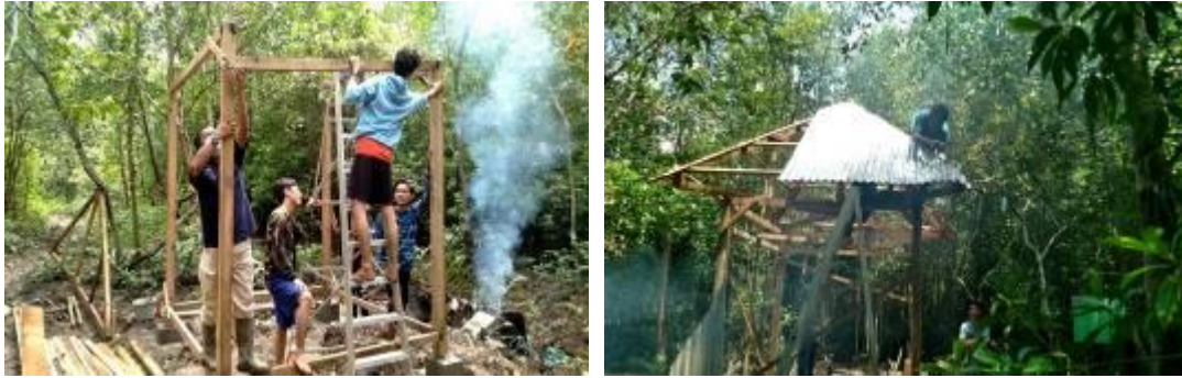
Gambar 6. Pemasangan tiang, balok atas dan rangka kuda-kuda atap dan Pemasangan atap seng
