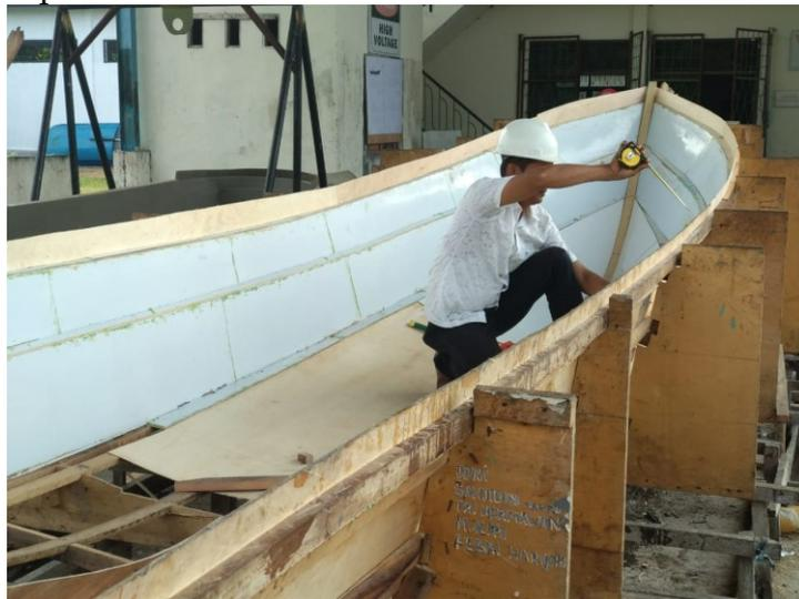
Gambar 3. Pengukuran Tinggi lambung
