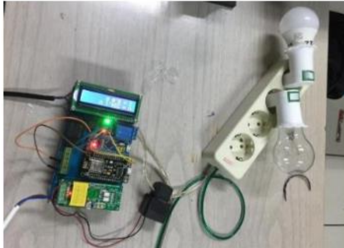
Gambar 9. Kondisi Ketika pelanggan mengalami pemadaman
