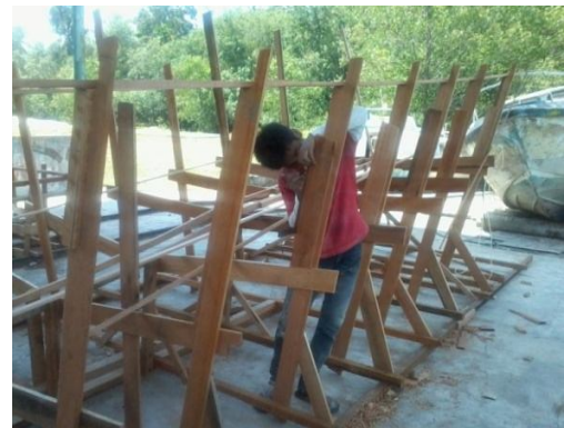
Gambar 2. Pemasangan Gading atau Frame untuk Cetak atau Mall
