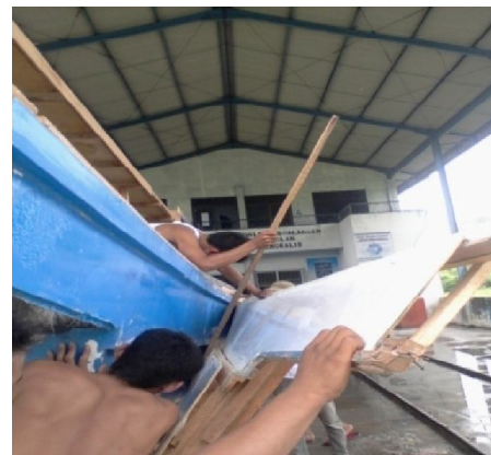
Gambar 5. Awal Pelepasan Cetakan
