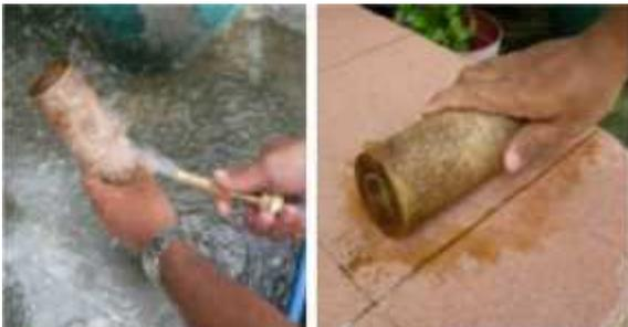
Gambar 1. Proses pembersihan *cartridge filter* secara manual
