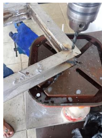
Gambar 12. Proses pengeboran lubang baut
