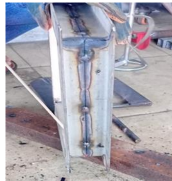
Gambar 11. Proses pengelasan penuh pada vacuum box
