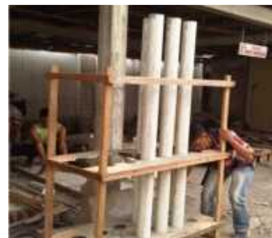
Gambar 7. Tiang Pancang beton
