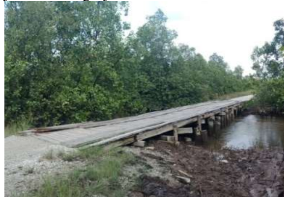
Gambar 1 Kondisi jembatan Sungai Jalan Antara
