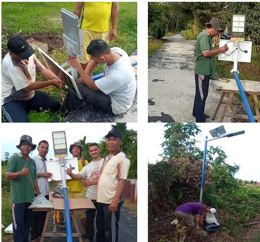
Gambar 6. Perakitan, Pengujian dan Pemasangan unit PJUTS 2 in 1
