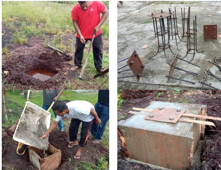
Gambar 5. Pembuatan pondasi beton (dudukan tiang)
