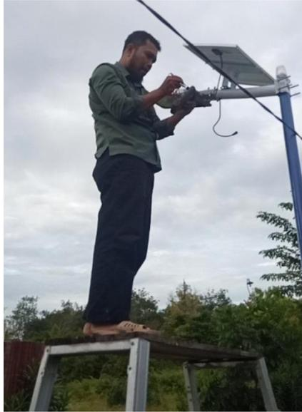
Gambar 7. Pengujian dan pengukuran komponen PJUTS 2 in 1 terpasang (zulkifli dkk, 2022)
