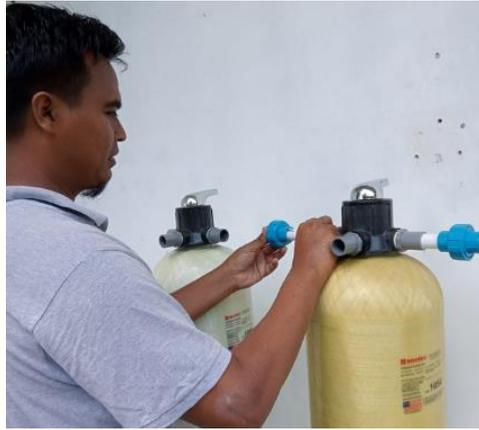
Gambar 6. Pemasangan tabung macrofilter
